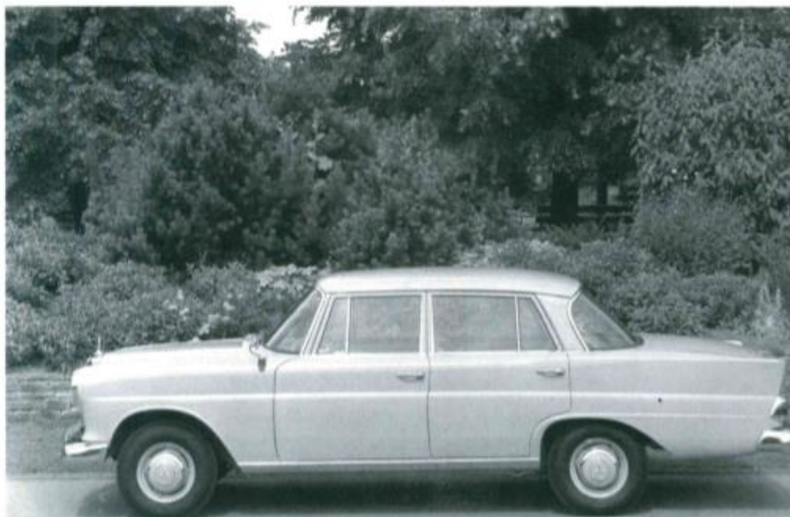
A korai 190-esek egyike: bordázott hátsó lámpák és a visszapillantó tükör még a sárvédőn van
